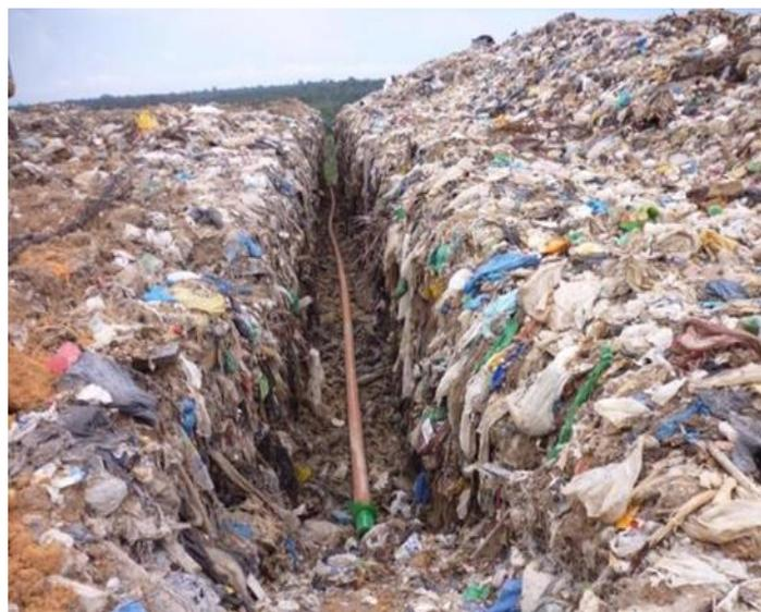
Figura 4: Instalação de um Dreno horizontal.
