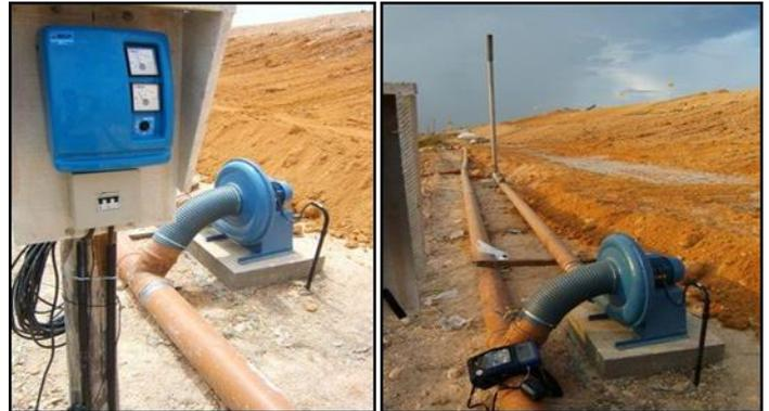
Figura 1: sistema piloto de captação de biogás. Fonte: Acervo do Aterro de Manaus. Fonte: Autores, (2018).
