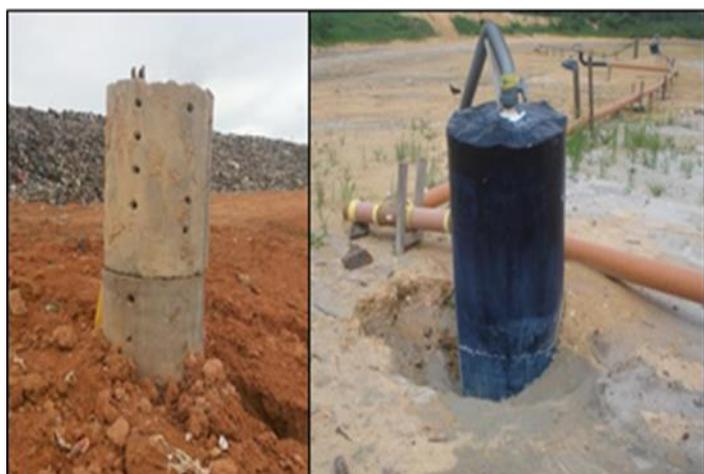
Figura 3: Dreno vertical antes e após ser conectado ao sistema de coleta.
