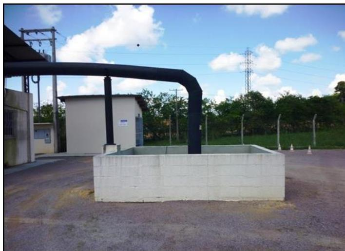
Figura 6: Caixa de remoção de condensado.
