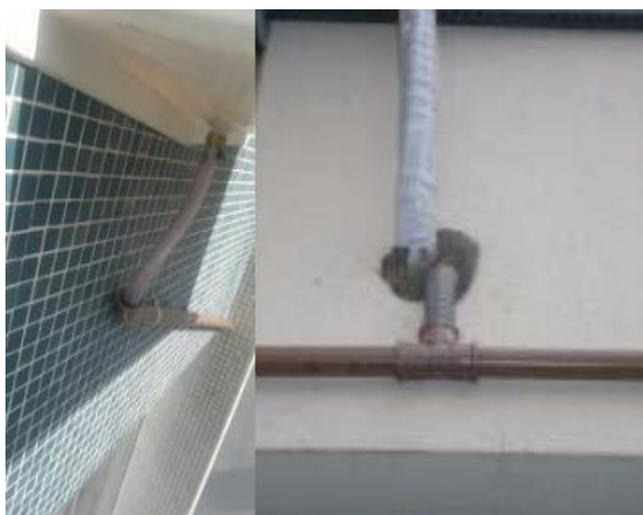
Figura 4. Conexão dos tubos de PVC ligando cada aparelho.
