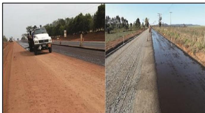
Figura 5: Aplicação da emulsão asfáltica de imprimação (EAI).
