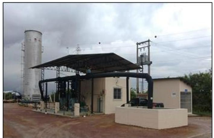
Figura 2: Planta de Captação e Queima de Biogás do Aterro de Manaus.
