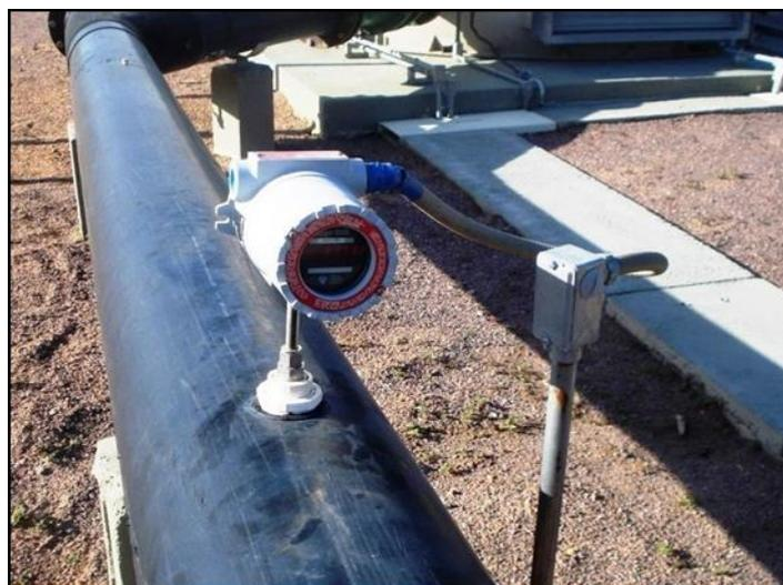
Figura 9: Medidor de Vazão de LFG.
