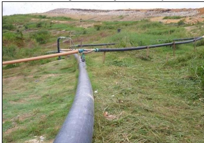
Figura 5: Tubulação de coleta em PEAD 315 mm.
