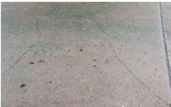
Figura 10: Fissuras diagonais.
