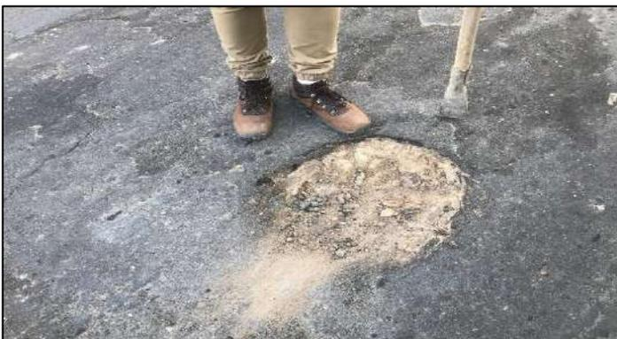
Figura 5: Realização de cortes nas bordas do buraco no local identificado
