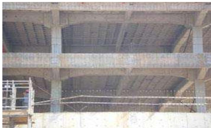
Figura 5: Lajes nervurada.
