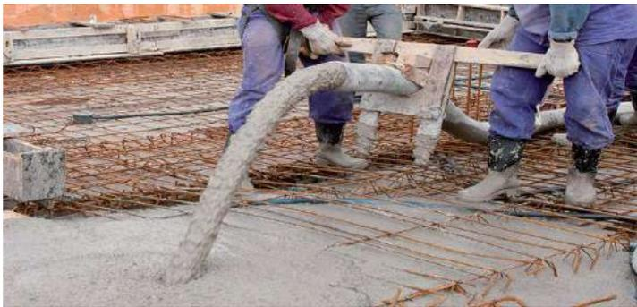
Figura 13: Concretagem das lajes nervuradas.
