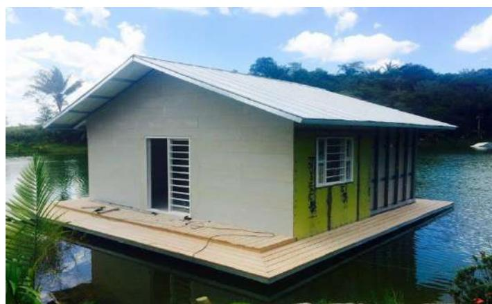
Figura 2: Casa flutuante construída pelo sistema Light Steel Frame na cidade de Manaus, AM. Fonte: Planalto Industrial Ltda. Fonte: Autores, (2018).
