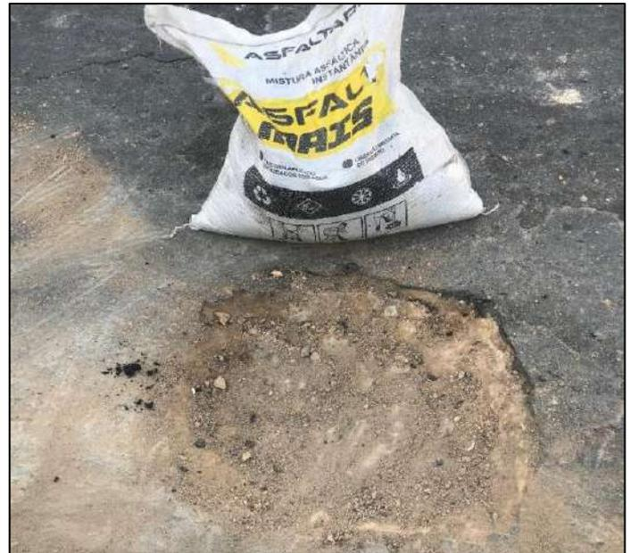
Figura 6: limpeza do material Solto
