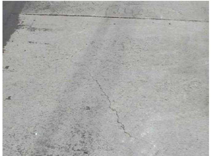
Figura 16: Fissuras superficiais.
