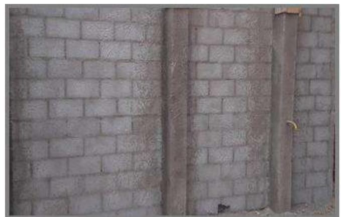
Figura 9: Muro de arrimo concluído.
