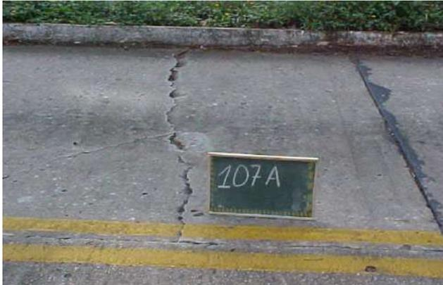
Figura 8: Fissuras transversais.
