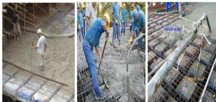
Figura 14: Concretagem das lajes nervuradas
