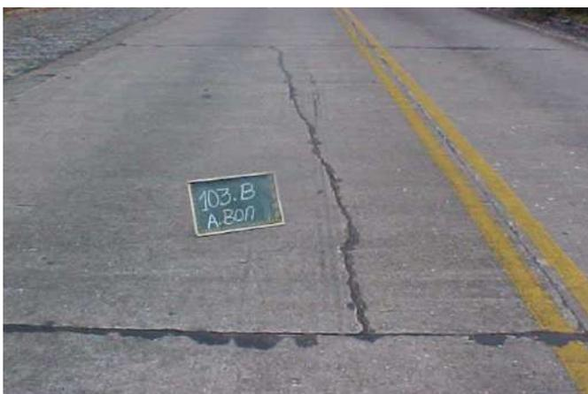
Figura 9: Fissuras longitudinais.
