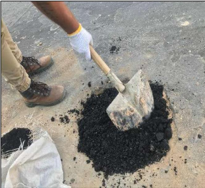
Figura 8: Espalhar a massa asfáltica uniformemente
