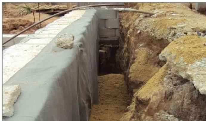
Figura 2: Representação do escoramento do solo para aplicar manta geotêxtil, com o objetivo de impermeabilizar.
