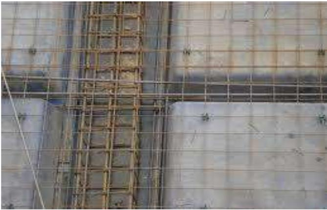
Figura 12: Armação de lajes nervurada moldada no local.
