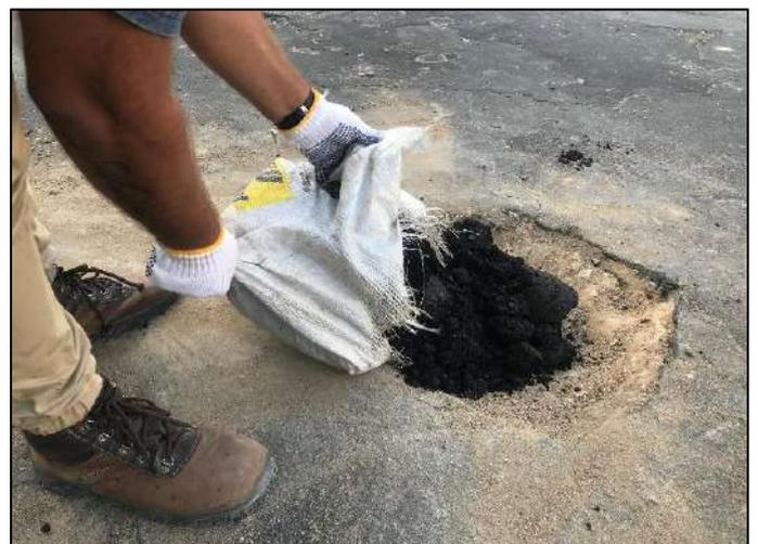
Figura 7: Aplicação da massa Asfáltica
