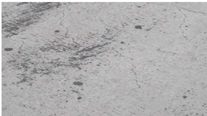
Figura 17: Fissura de retração plástica.
