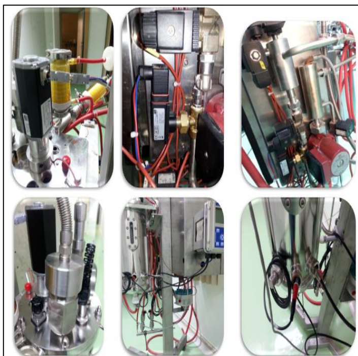
Figura 6: Montaje de sensores/transmisores y actuadores. Fuente: autores, 2017.
